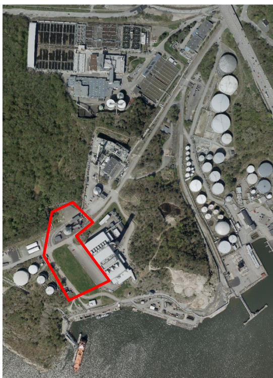
Figur 10. Flygfotot över Ryahamnen. Röd markering visar exempel på placering av anläggning.
